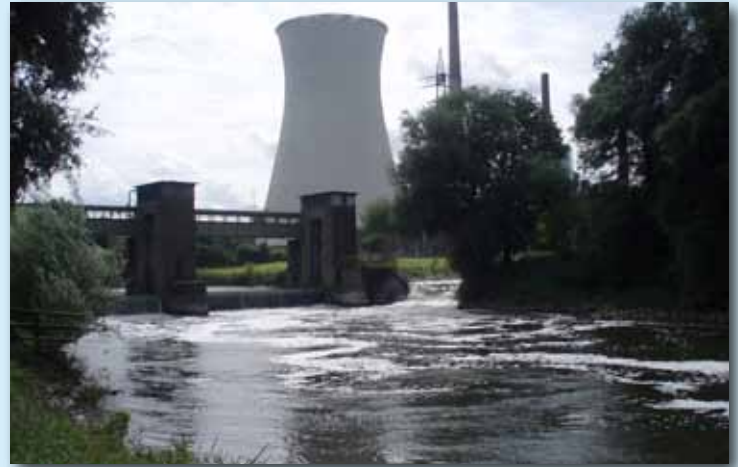
Mehrere Kraftwerke nutzen das Wasser der Lippe zur Kühlung.
