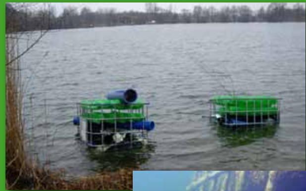
Gitterboxen in Ufernähe kurz vor dem Versenken.
