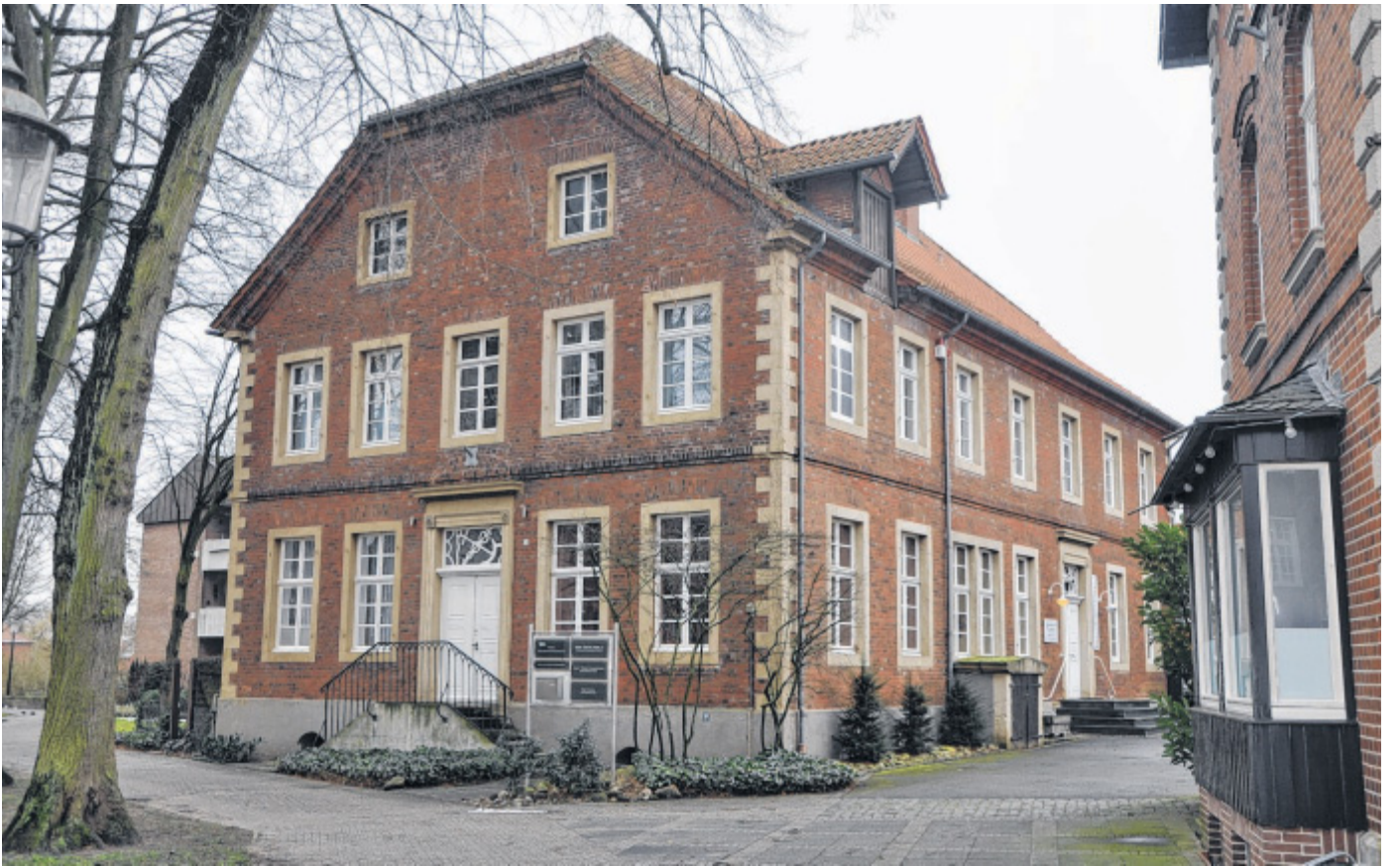
Könnte ein Projekt werden: Eine nachträgliche Förderung für den Verein „Haus Samson“ gibt es nicht, wohl aber für aktuelle Sanierungsarbeiten.
